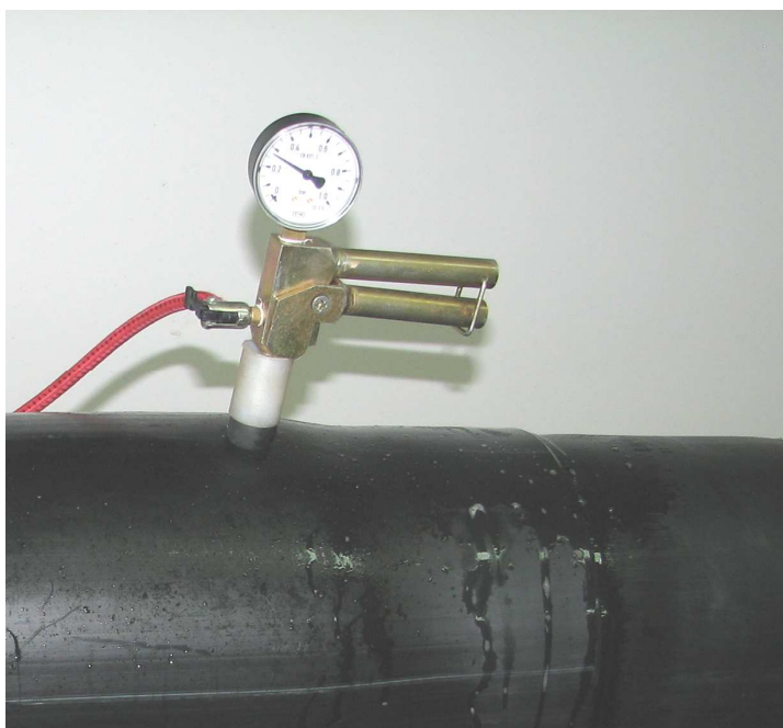
Fot. Nr 34 Wypełnienie złącza powietrzem.
